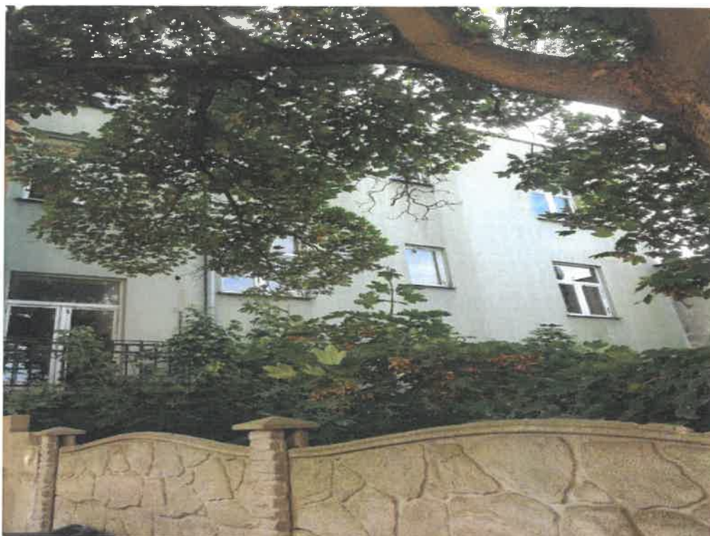
Fotografia nr 2. Elewacja tylna od podwórza.
