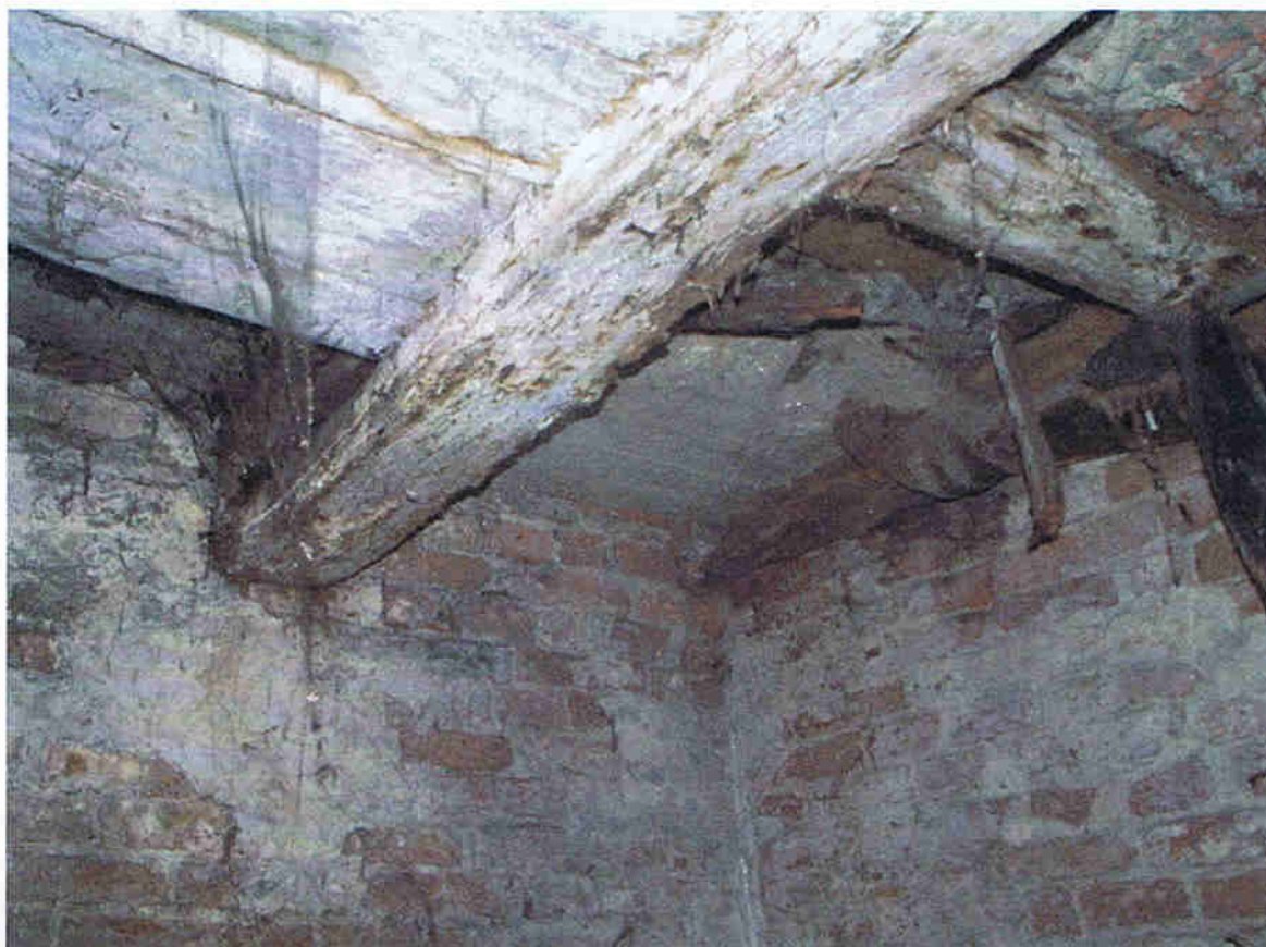
Fot. 8 Strop pod klatką schodową
