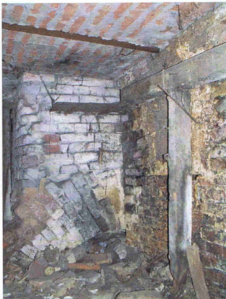
Fot. 16 Ściana piwniczna z nadprożem łukowym
