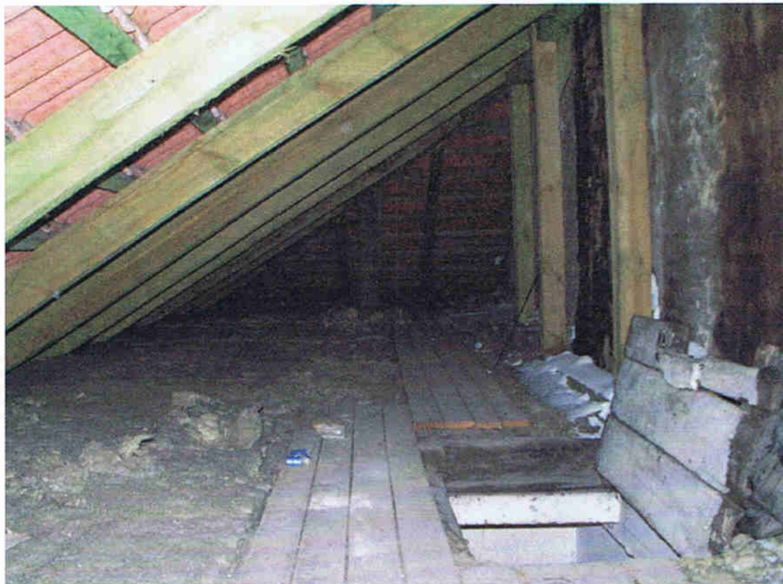
Fot. 4 Widok strychu budynku Grodzka 1
