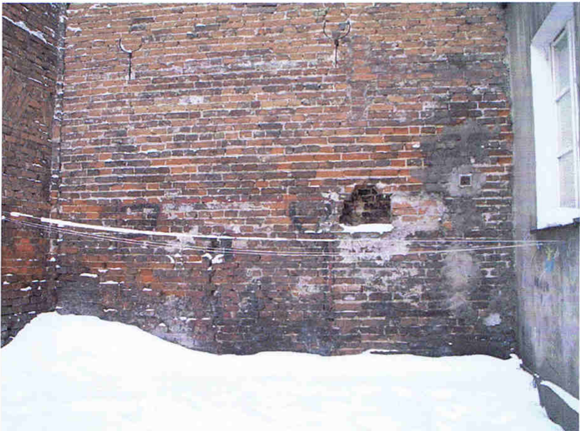
Fot. 2 Elewacja tylna budynku Grodzka 1
