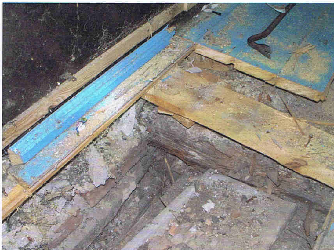
Fot. 6 Odkrywka S2 - strop nad I piętrem
