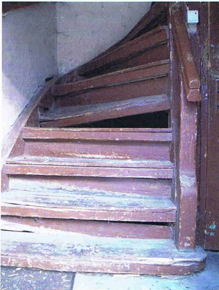
Fot. 15 Drewniane schody wewnętrzne w budynku Grodzka 1
